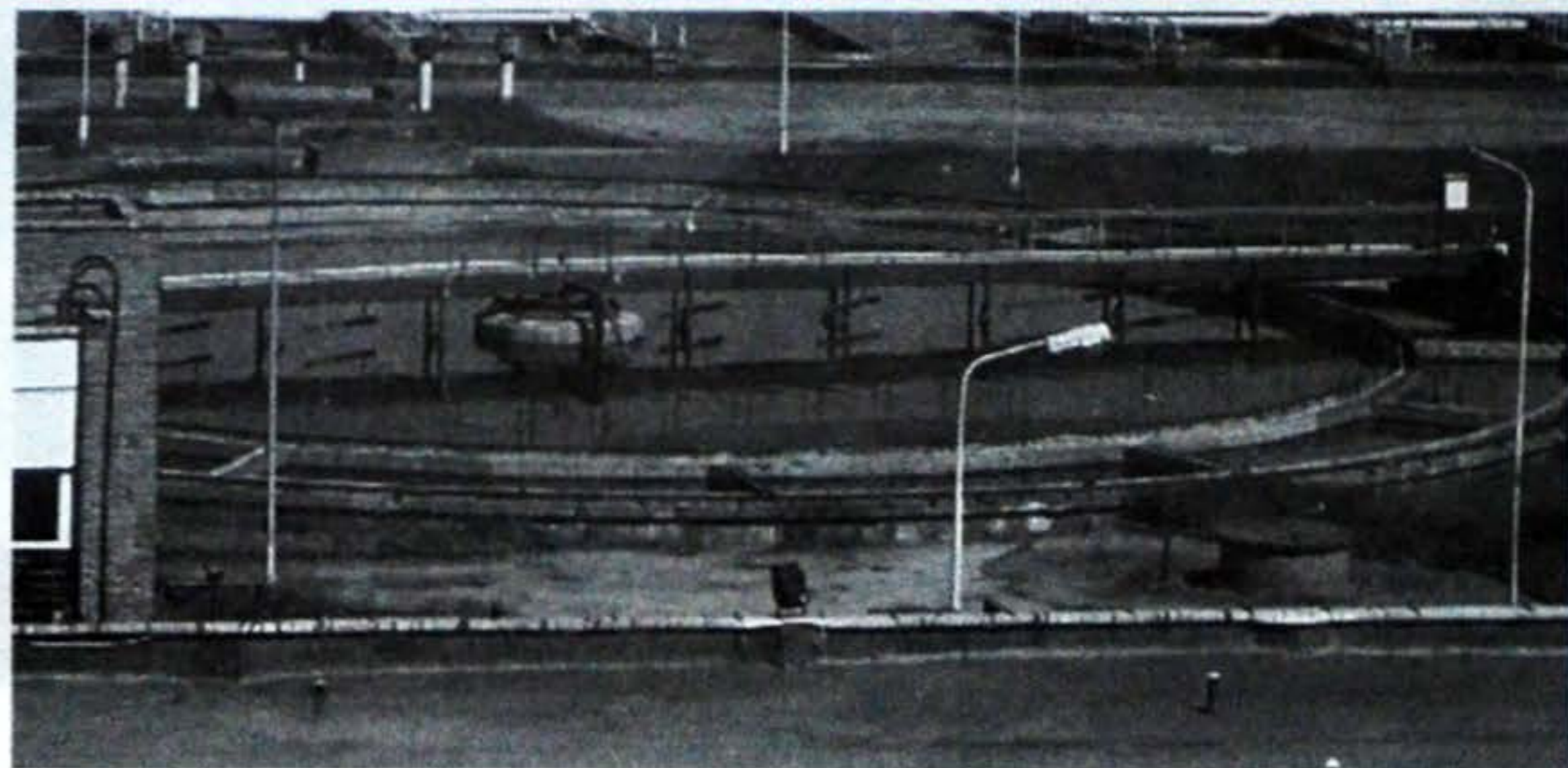
Завод по очистке сточных вод Вильнюсского водоканала
